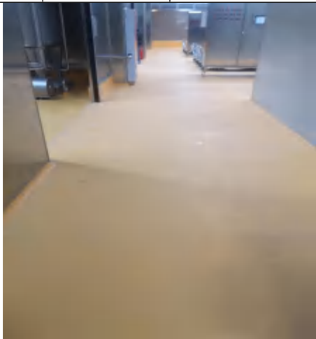
生产车间地面
