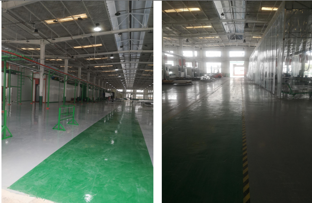
1#厂房和 2#厂房地面
