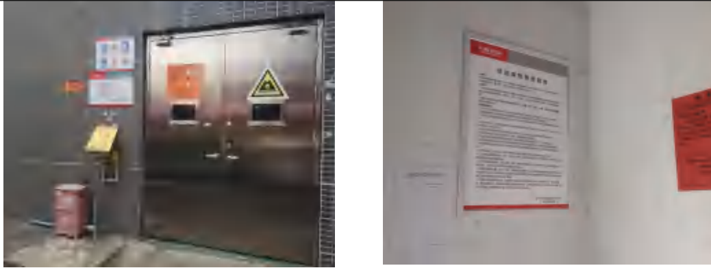
依托危废暂存间 图 3-3 固废暂存设施照片
