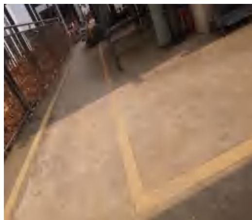
污水处理站地面
