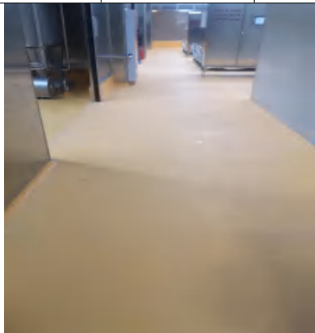
生产车间地面
