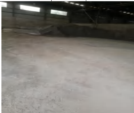
生产车间地面
