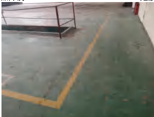
机修车间地面
