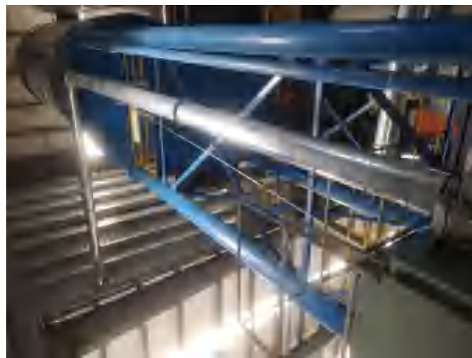
粉料自动衔接输送口粉尘收集处理及排气筒
