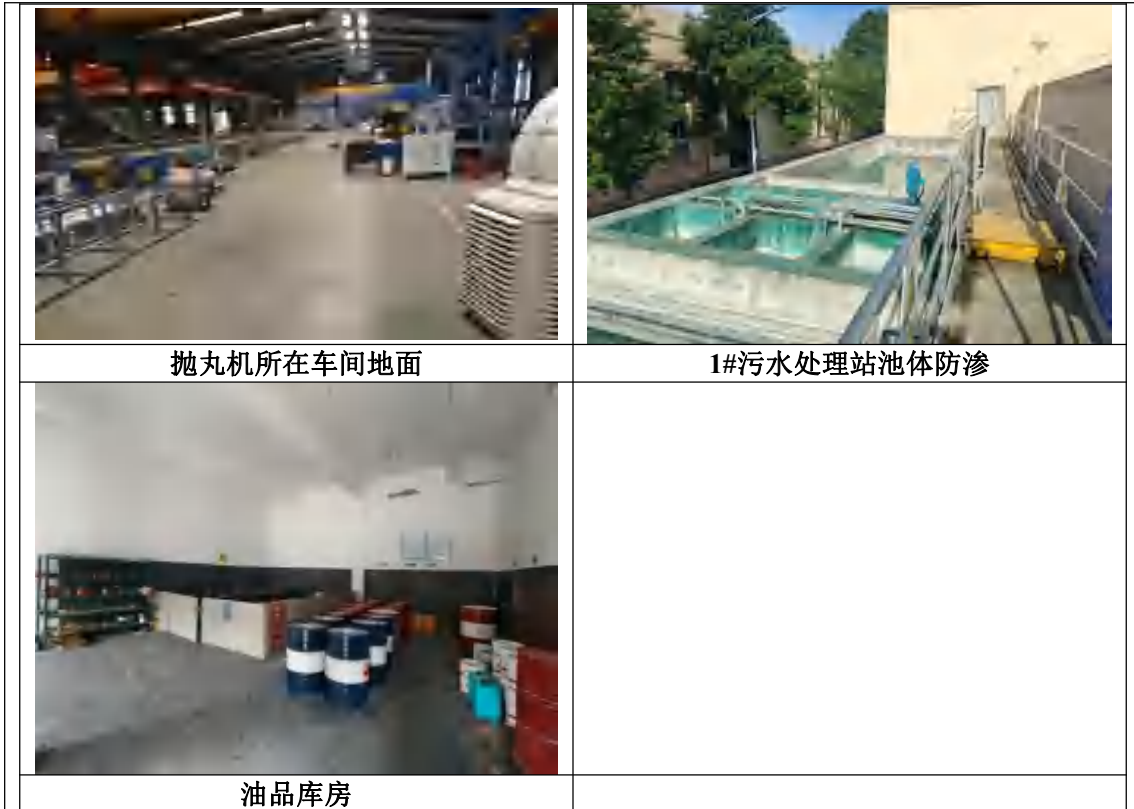
图 3-4 采取防渗措施地面照片
