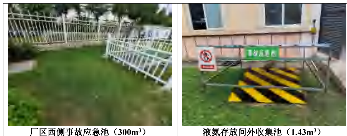
图 3-5 已设置事故应急池
