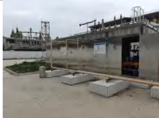
天然气掺氢混气站地面
