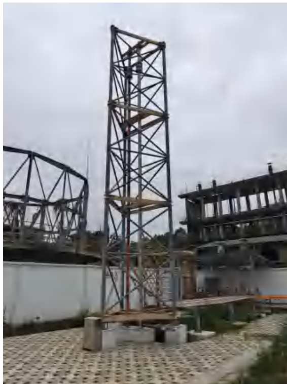
图 3-1 放空塔（设置 2 根放空管）
