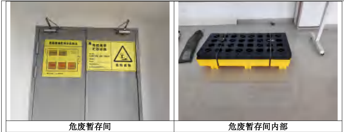
图 3-2 固废暂存设施照片
