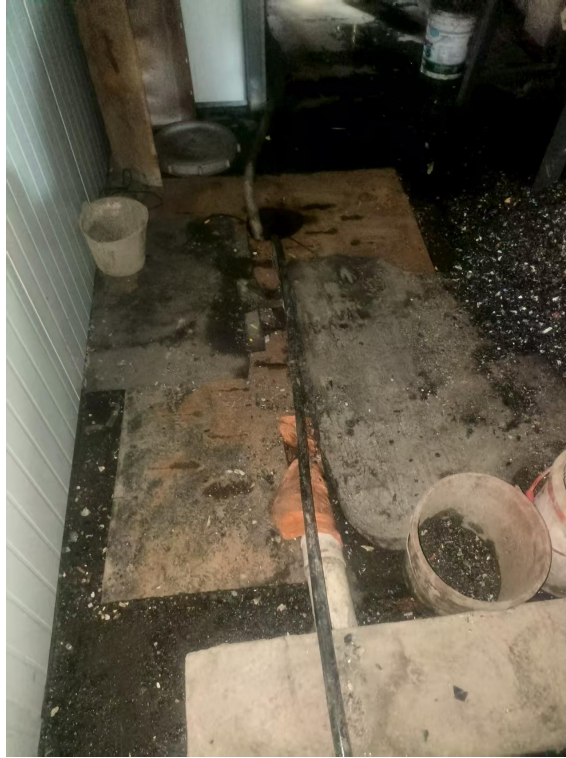
图 3-1 地埋式三级沉淀池
