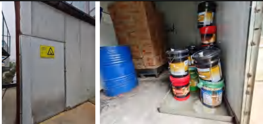
图 3-4 依托危废暂存间
